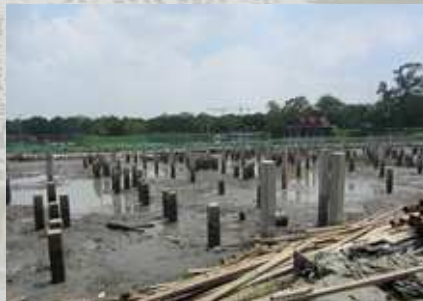
สถานที่ตั้งและการก่อสร้างหอจดหมายเหตุฯ (พ.ค. ๒๕๕๒)
